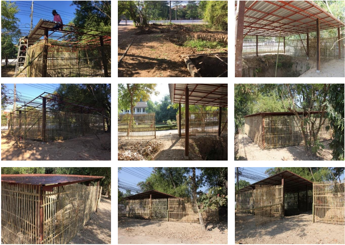
งานหลุมปุ๋ยหมักอินทรีย์
