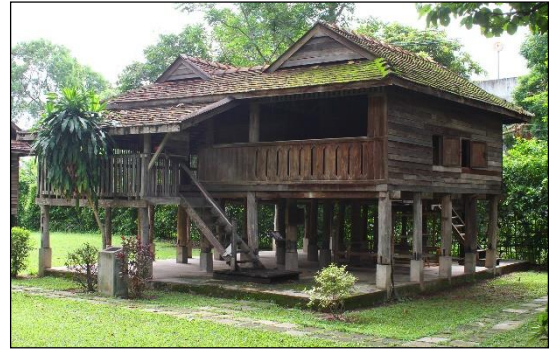
8. เรือนพื้นถิ่นแม่แตง สร้างปี พ.ศ. 2460
