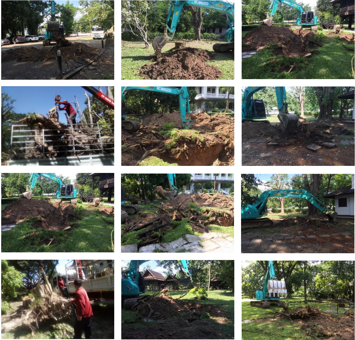
งานปรับผิวดิน และถมดินบริเวณที่เป็นหลุมเป็นบ่อ
