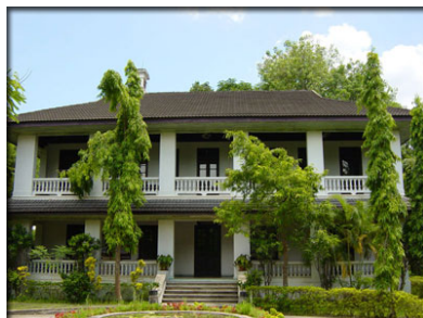
เรือนทรงโคโลเนียล (ลุงคิว) อาคารสำนักงานสำนัก พ.ศ. 2465 - 2537
